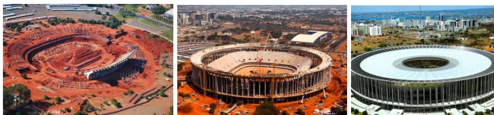
Figura 5 – Construção do Estádio Nacional de Brasília. Fonte: portal2014.org.br
